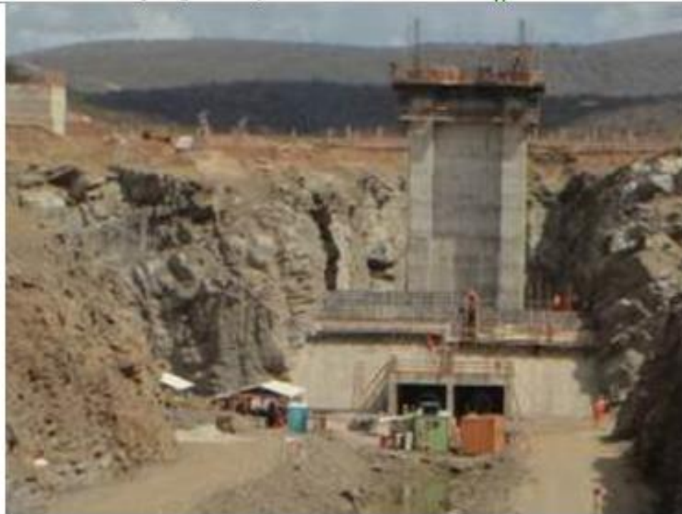
Início do Canal – Execução da Estrutura em Concreto p/ as Comportas Planas Verticais da Tomada D'Água do Canal (Lado Jusante) (2014)
