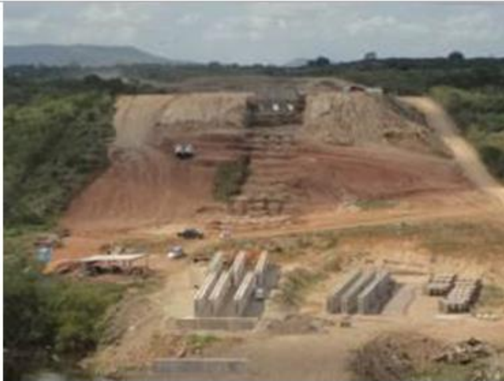
Sifão Ingá – Vista Superior Vista Superior em execução (Estacas – E-642 a E-668) (Ex.2014)
