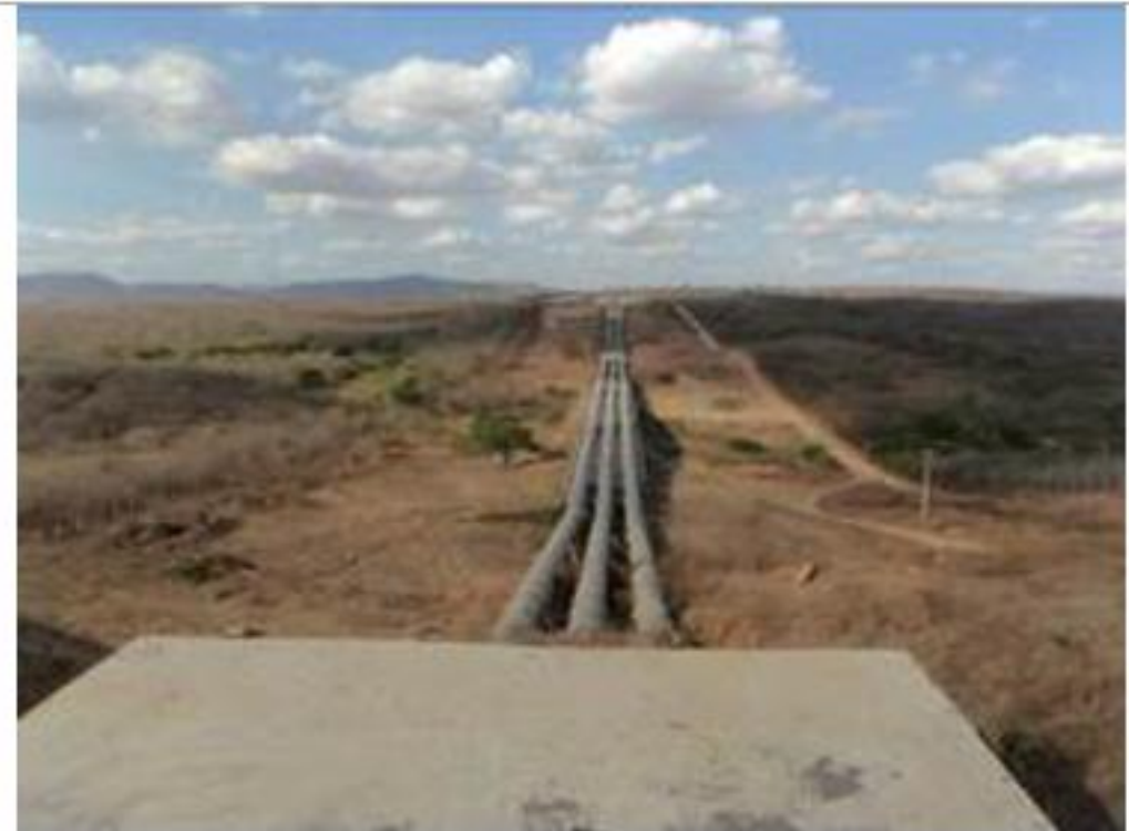
Sifão Ingá – Vista Superior em conclusão dos trabalhos (Estacas – E-642 a E-668) (Ex.2016)
