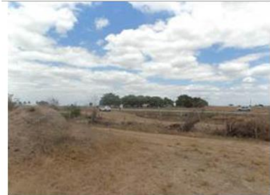
Local da Passagem Rodovia-BR-230 – Estaca: E-2277 Apenas execução das Cercas da Faixa Domínio Canal
