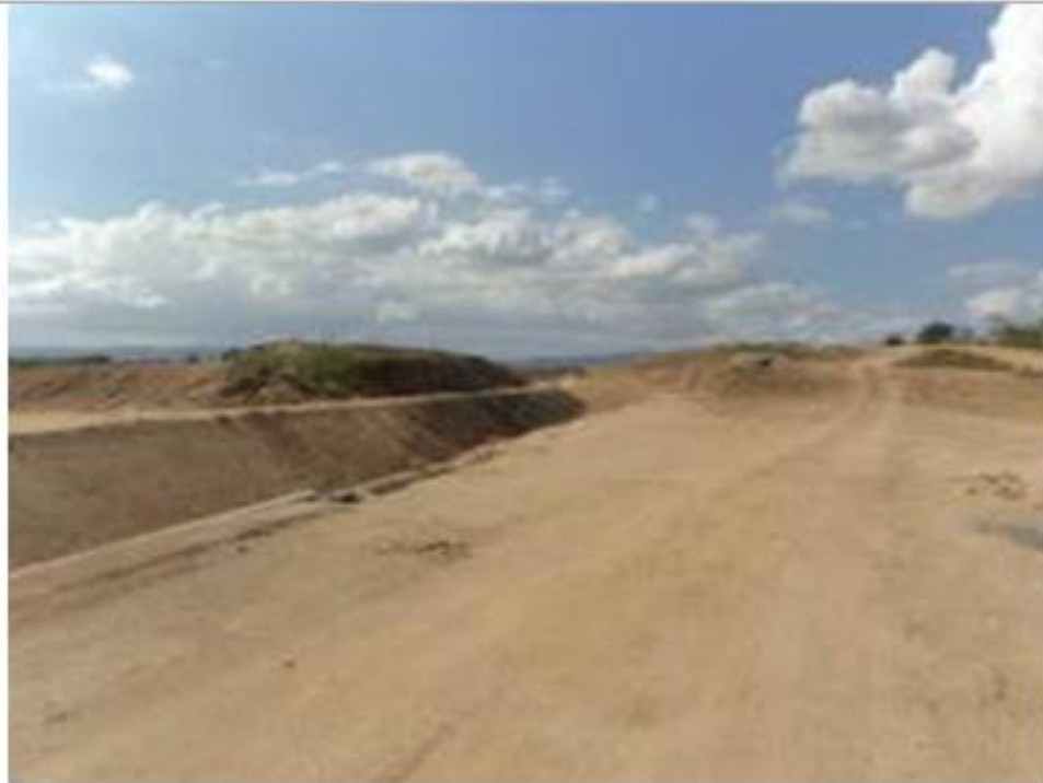
Escavação da Seção do Canal (Estacas E-681 a E-883: 4Km ) (Ex.2014)
