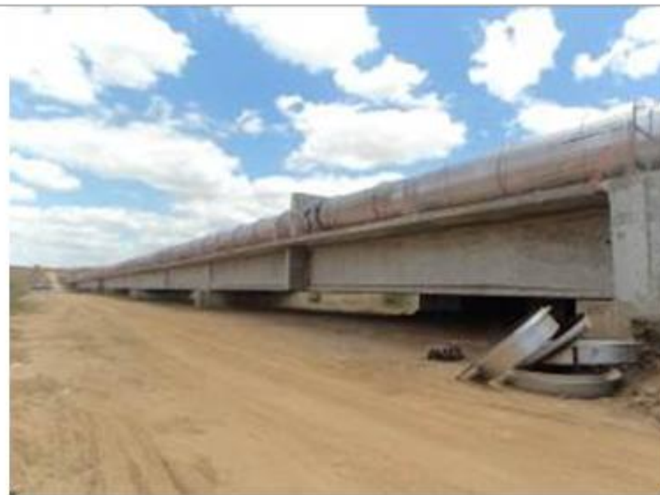
Sifão Curimataú – Tubulação Metálica - (três linhas de Tubulação) – sobre Ponte do Rio Curimataú (Estacas E-2075 a E-2093) (Ex. 2016)
