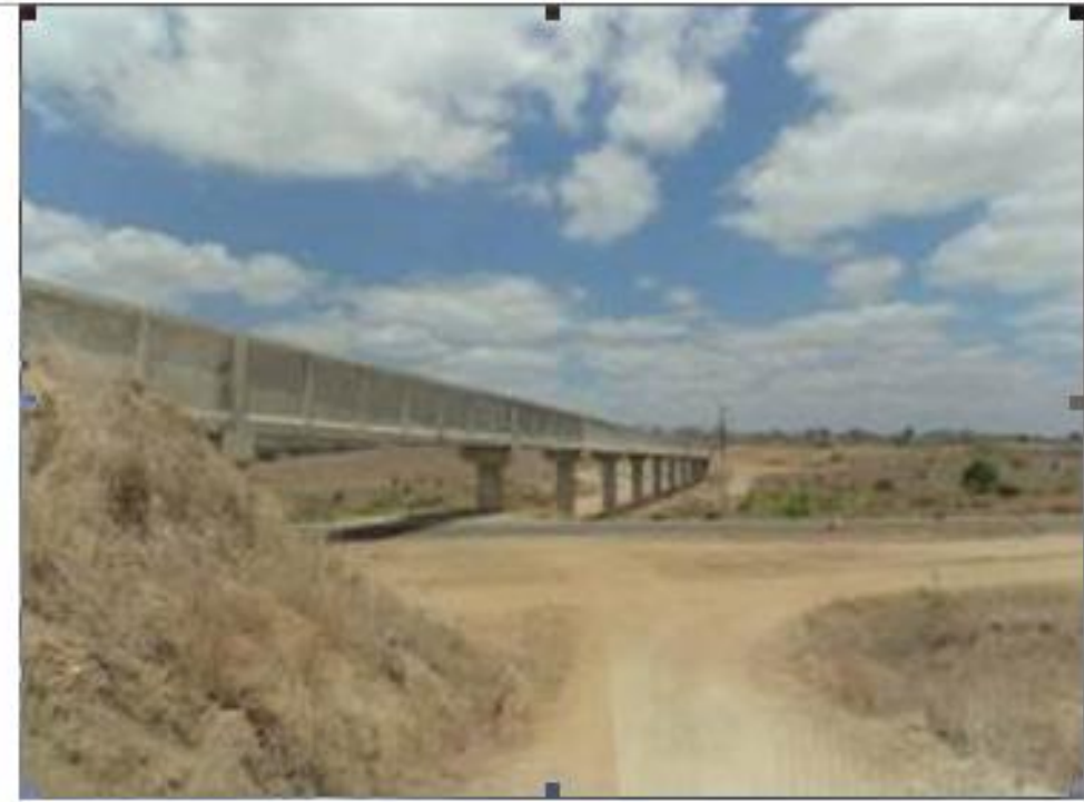
Aqueduto Mogeiro – Em Conclusão - Vista Longitudinal – com detalhe da Rodovia – PB-66 (transversal ao canal) Estaca – E-1023 a E-1037 (Ex.2016)
