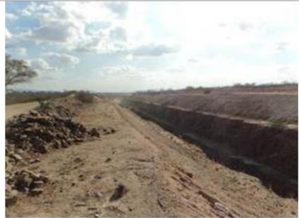
Escavação da Seção do Canal (Estacas – E-746 a 849: 2Km ) (Ex.2016)
