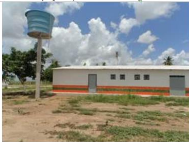
Canteiro de Obras – Lote2 – Não estava sendo utilizado, Não havia Instalações (Elétricas, Hidráulicas, etc.) (Ex.2014)
