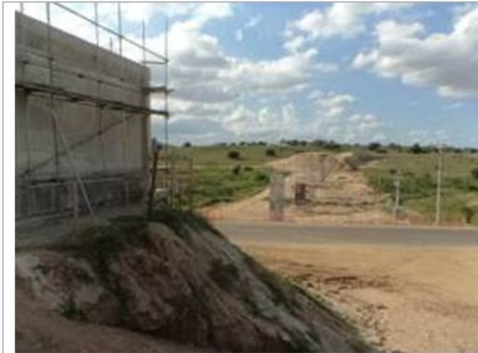
Aqueduto Mogeiro – Em construção - Vista Longitudinal – com detalhe da Rodovia – PB-66 (transversal ao canal) Estaca – E-1023 a E-1037 (Ex.2014)
