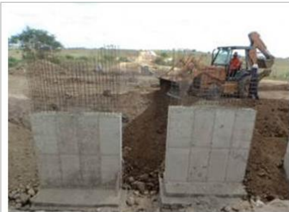
Sifão Curimataú – Execução dos Suportes em Concreto Armado para apoio das Tubulações Metálicas – Estacas – (E-2079 a E-2118) (Ex. 2014)
