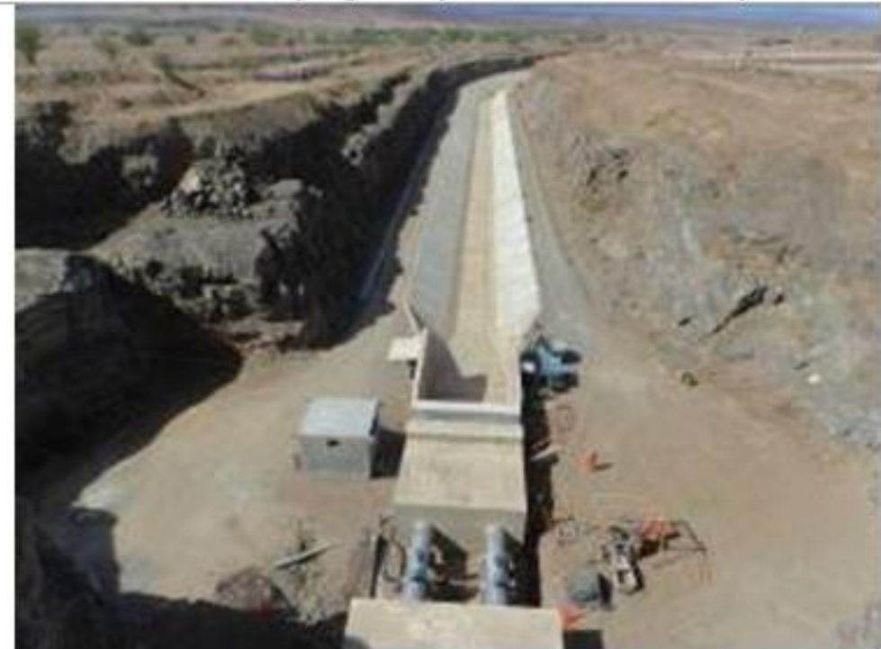
Início do Canal – Saída das Comportas Planas Verticais da Tomada D'Água do Canal (Lado Jusante), Canal em Placas de Concreto (2016)
