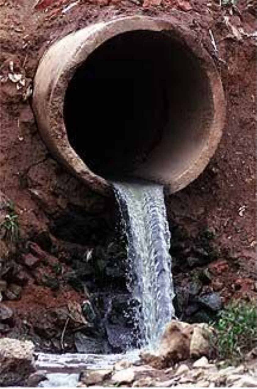
Lançamos esgoto sem tratamento
