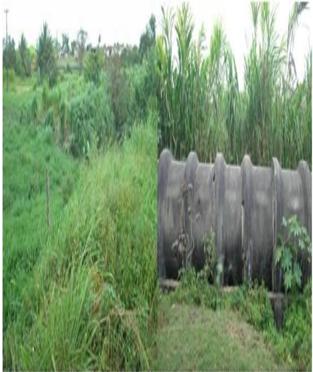
Desviamos esgoto para irrigação
